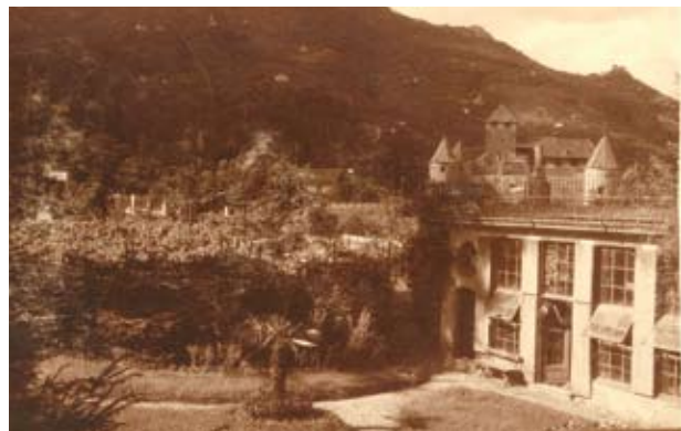
Wärmesaniertes historisches Gebäude, bei welchem der Energiebedarf von 450 kWh/m 2 a auf 30 kWh/m 2 a reduziert wurde.
